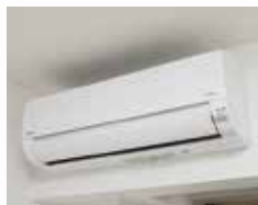
エアコン 各住戸にルームエアコン1基を標準装備しました。四季を通じて快適な空間を維持します。
